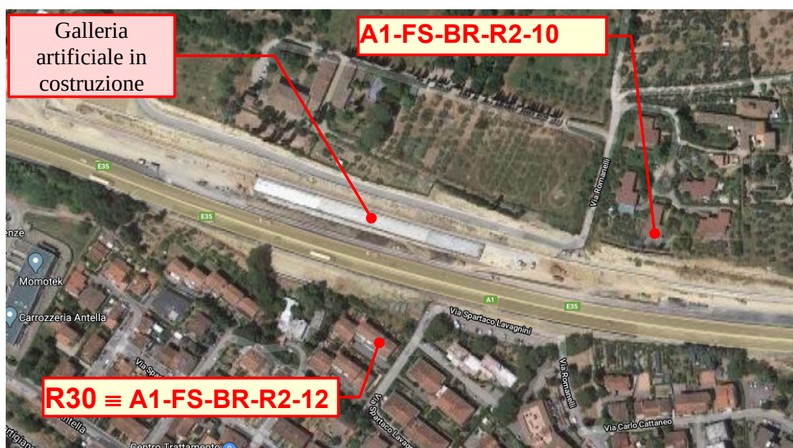
Figura 3: attuale configurazione del cantiere WBS GA01.
