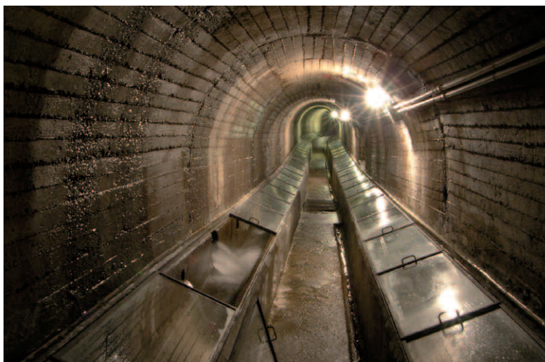
Figura 11 Captazione nel sottosuolo del monte Amiata di uno degli acquedotti che distribuisce acqua alle province di Siena e Grosseto, costruita agli inizi degli anni '50
