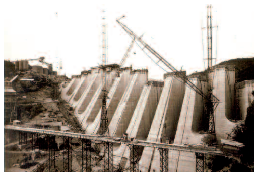
Figura 12 Costruzione della diga di Brugneto il cui invaso distribuisce ancora oggi l'acqua a Genova (1959)
