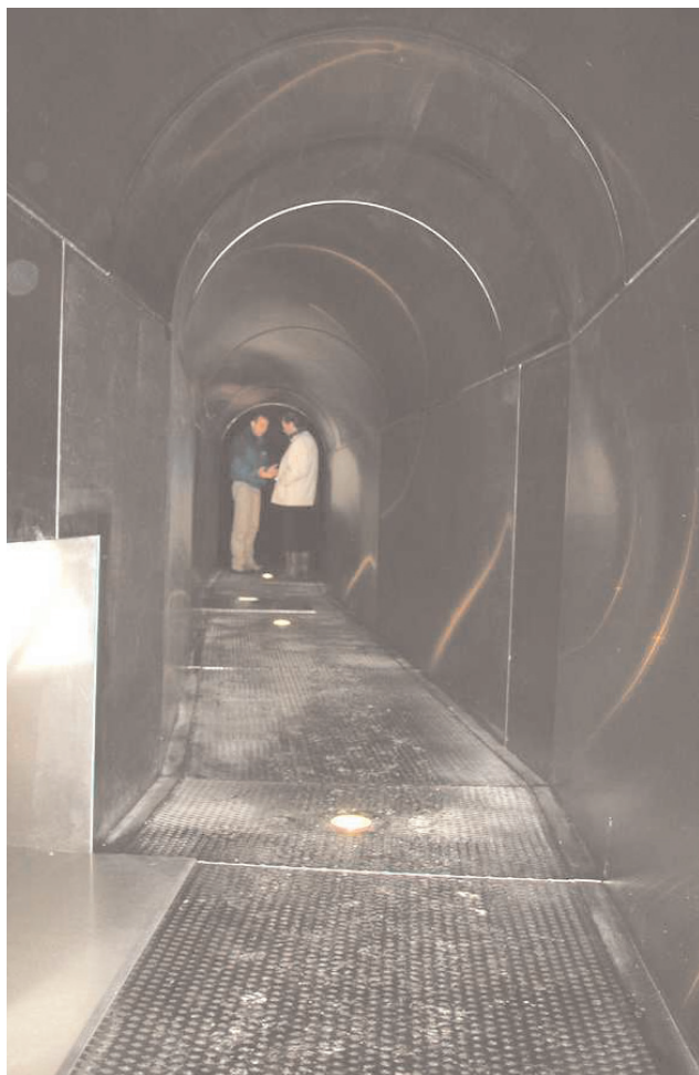
Figura 2 – Impiego dell'acciaio inossidabile in una galleria drenante per la captazione di acqua minerale.
