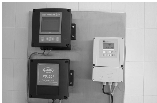
Figura 3 – Apparecchi installati nei pressi di una captazione di acqua minerale naturale per il monitoraggio di alcuni parametri.
