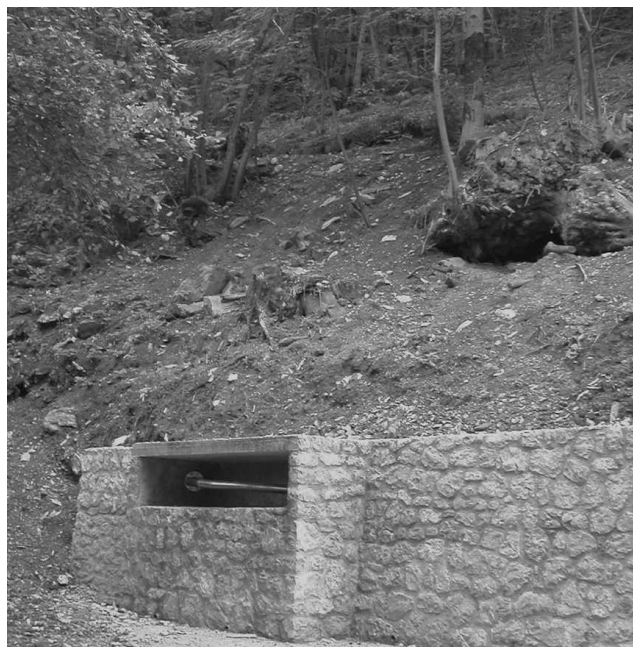
Figura 4 – Captazione di acqua minerale con tubazione suborizzontale in acciaio inossidabile
