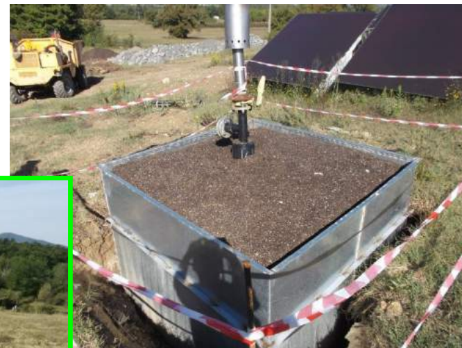
Riempimento dello scatolare
