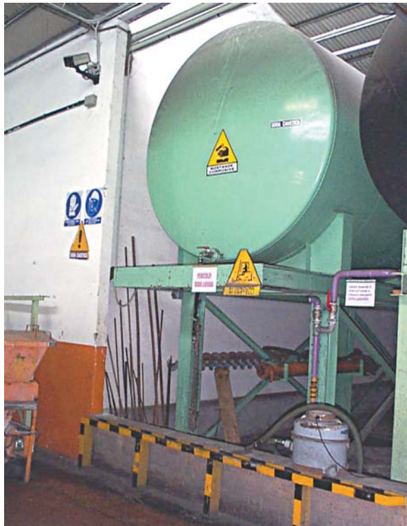
Foto 1 Serbatoio per stoccaggio soda liquida, con relativa vasca di contenimento
