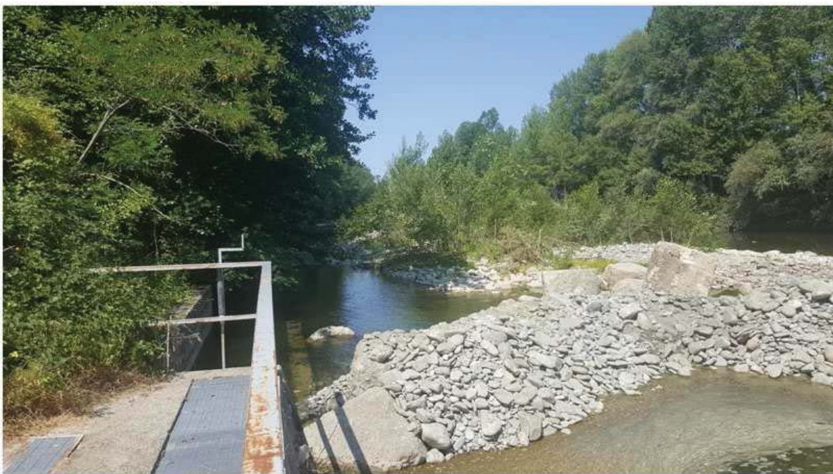
Località Buonriposo a monte e valle della sonda
