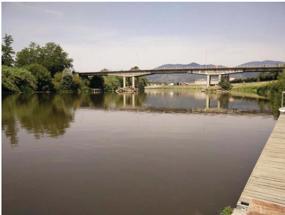
Località Calcinaia, vista a monte e a valle della sonda
