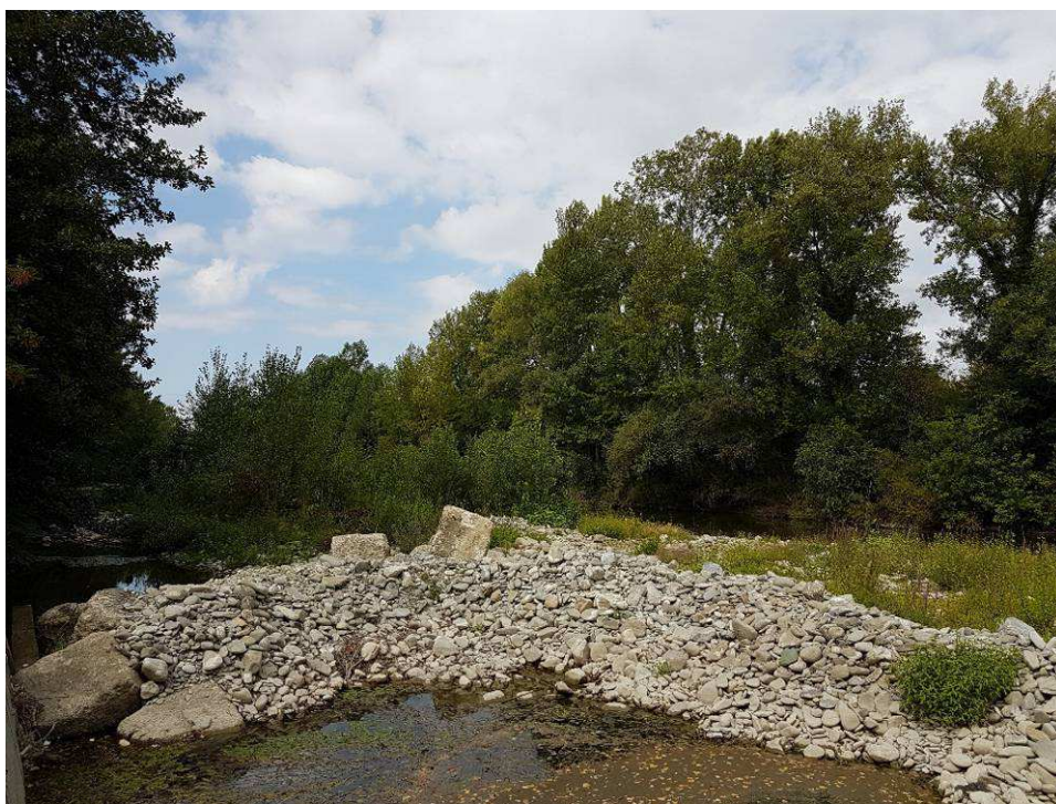
Località Buonriposo a monte e valle della sonda
