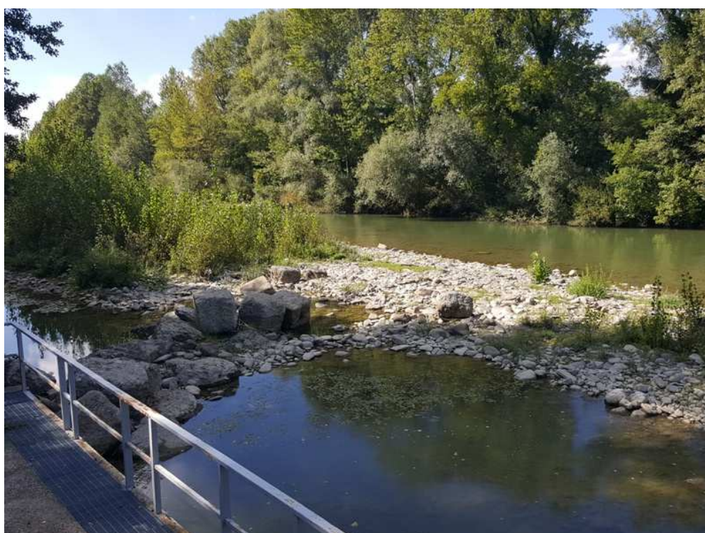
Località Buonriposo a monte e valle della sonda
