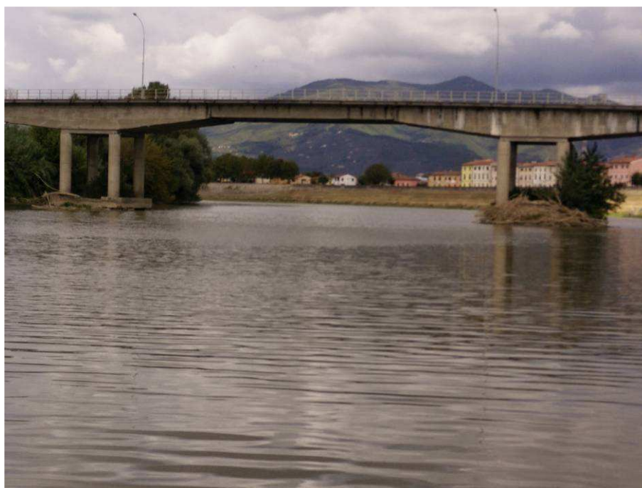
Ponte a Calcinaia , a monte a valle della postazione della sonda
