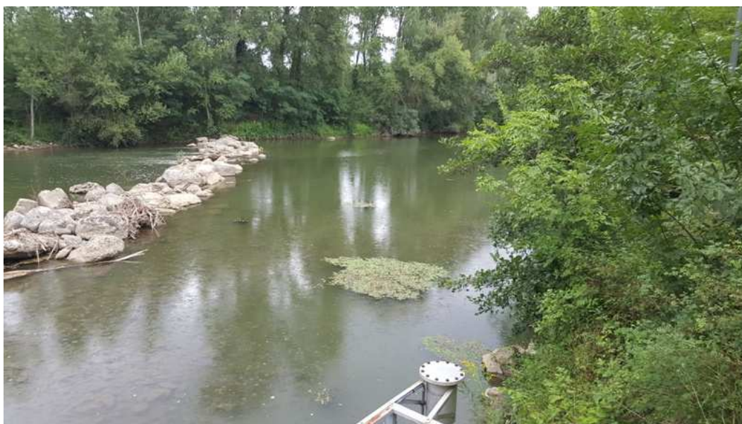
a monte centralina Buonriposo
