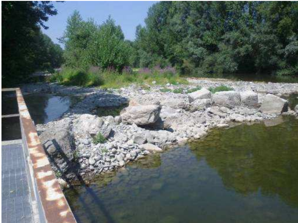
Buonriposo a valle della centralina
