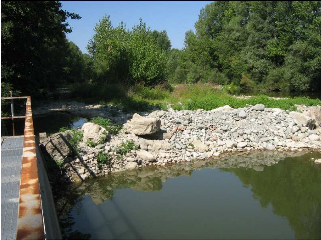
Buonriposo a valle della centralina
