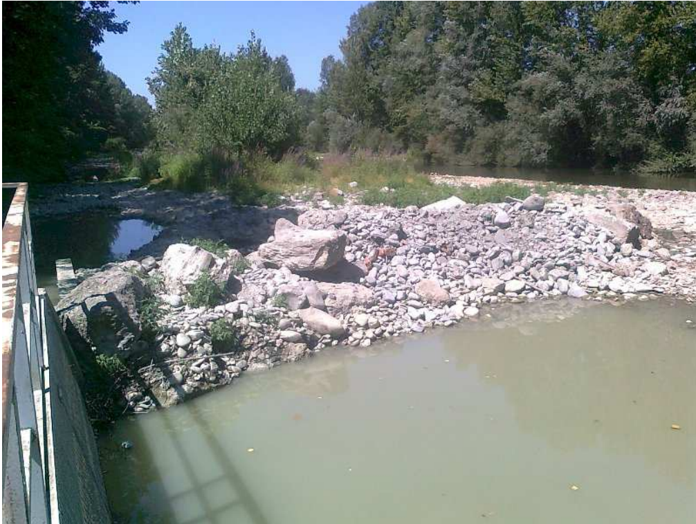
Buonriposo a valle della centralina
