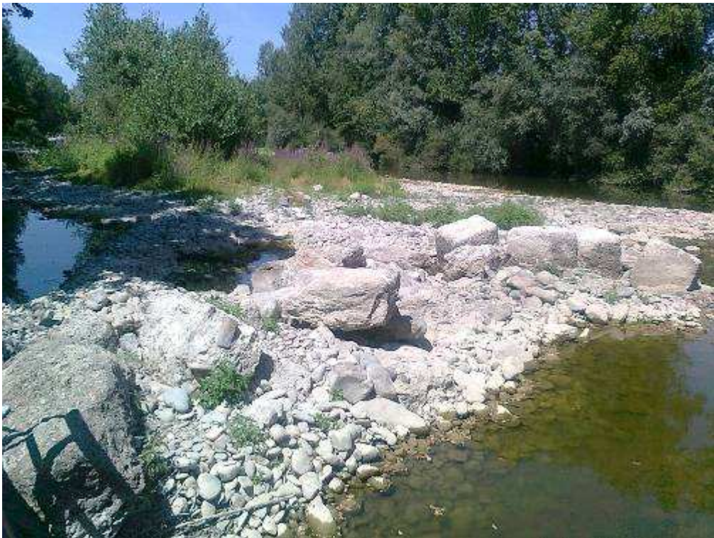
Buonriposo a valle della centralina
