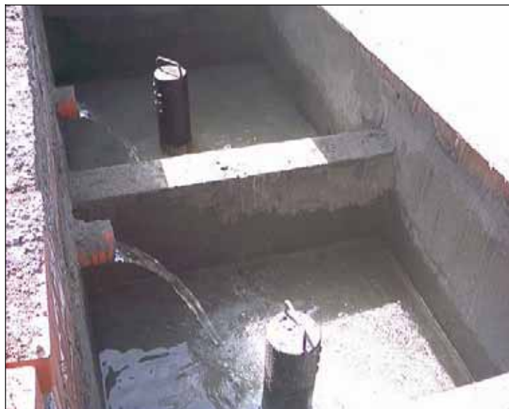
Figura 36. Sifoni per l'alimentazione del sistema a flusso sommerso verticale
