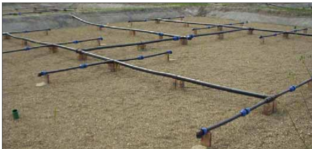
Figura 28. Impianto di Dicomano: particolare della vasca VF in fase di avvio dell'impianto
