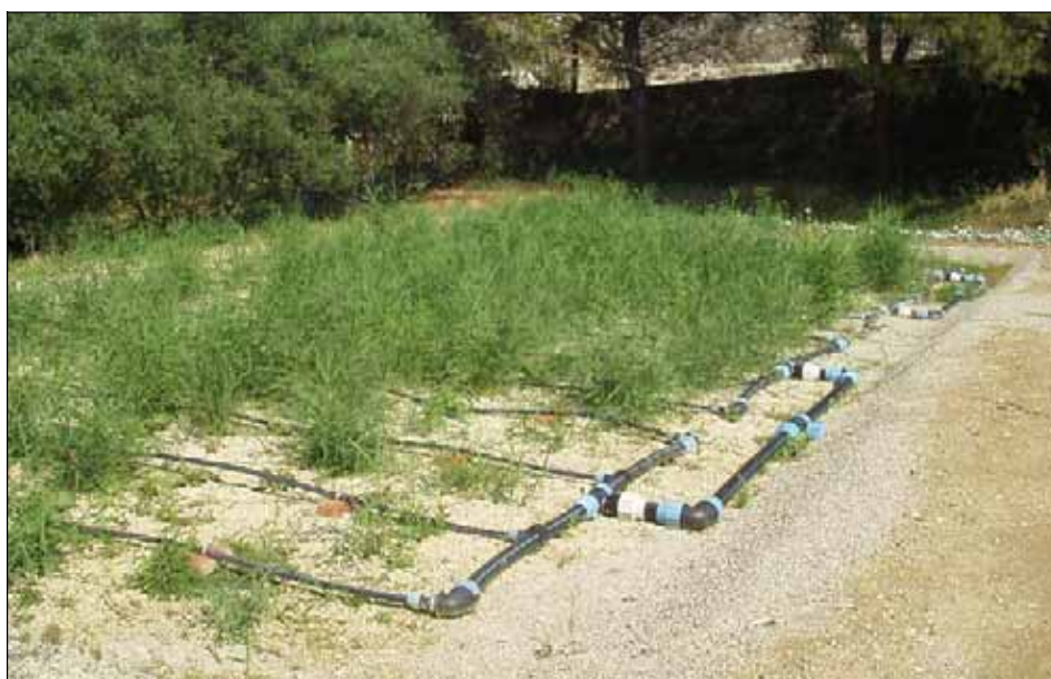
Figura 35. Sistema a flusso sommerso verticale in fase di avvio
