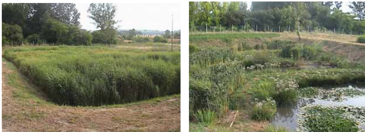
Figura 8. Sistema di fitodepurazione al servizio della Cantina Cecchi & Figli (Castellina in Chianti – SI), costituito da un sistema HF (foto a sinistra) seguito da un sistema a flusso libero FWS (foto a destra).
