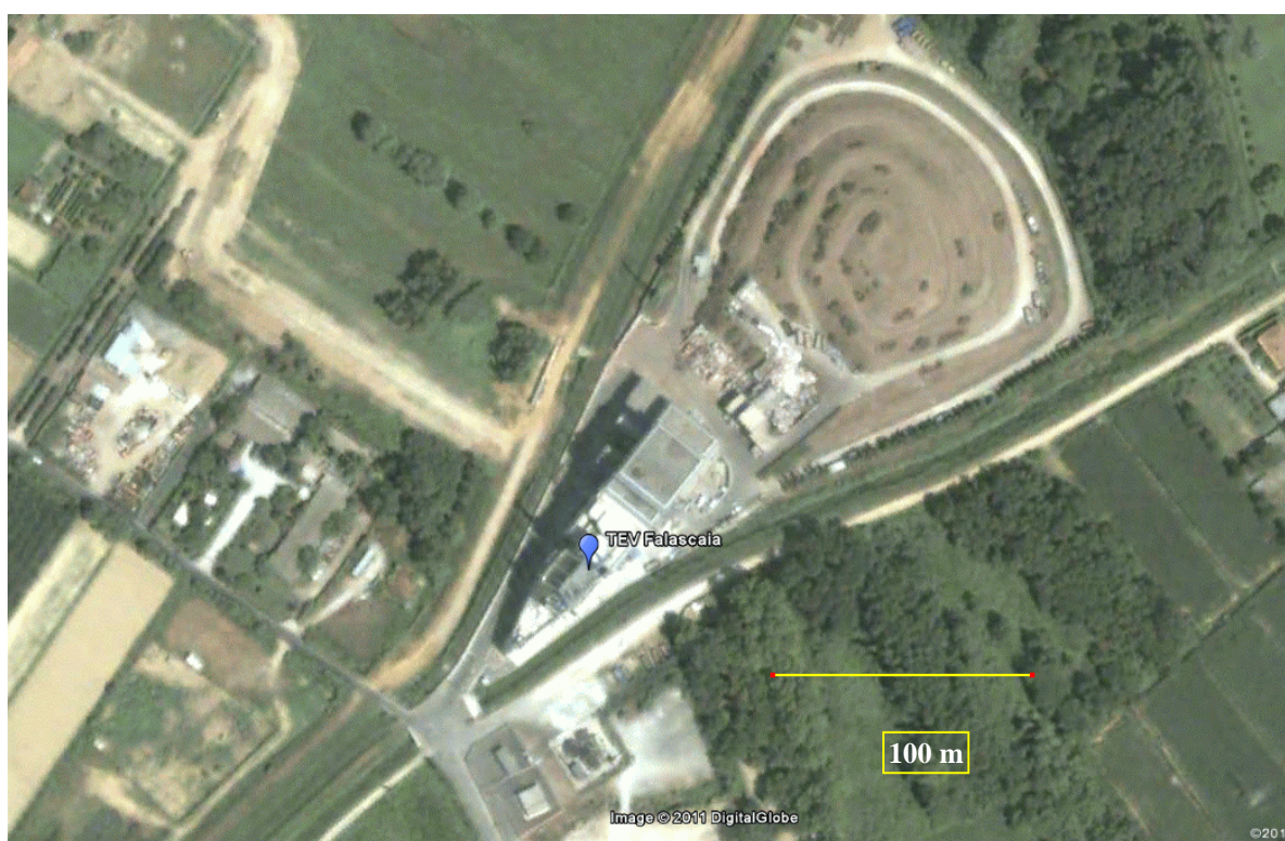
Figura B2: Immagine dell'impianto attuale, a NE del quale è visibile la zona che in passato e durante l'attività del vecchio impianto era stata destinata a discarica (immagine tratta da Google Earth).
