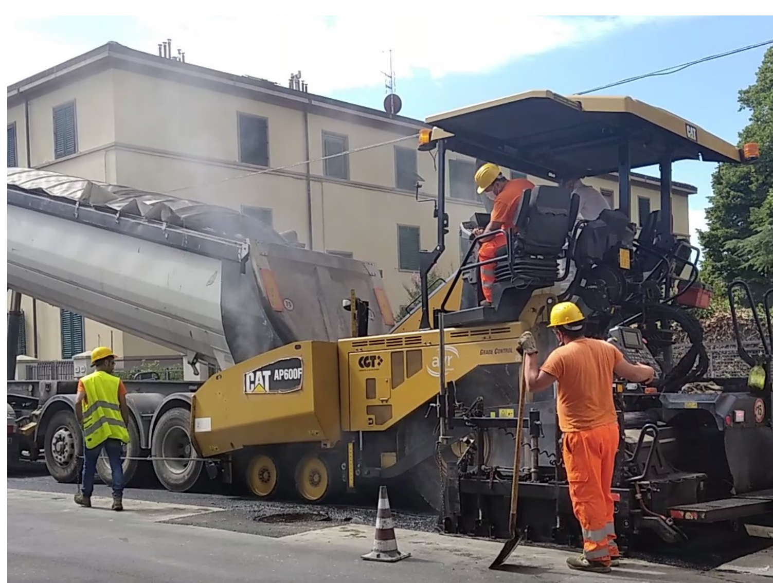
Stesura nuovo asfalto
