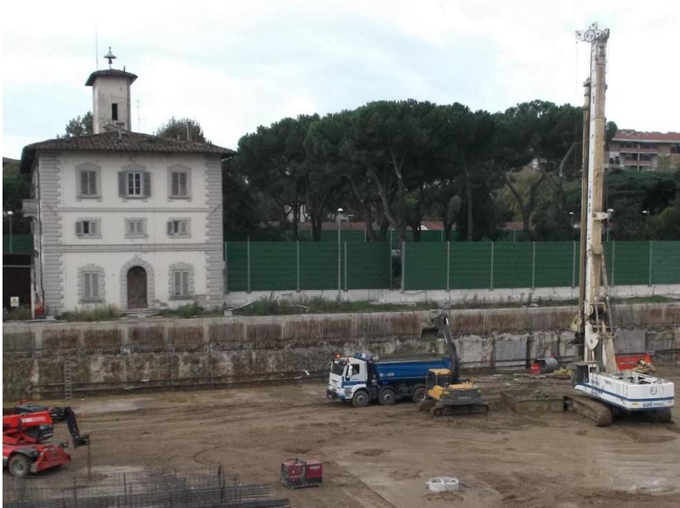
Fig. 2 - Perforazione palo
