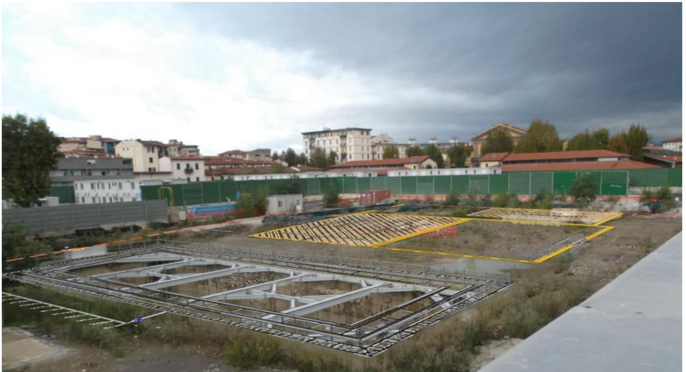
Fig. 1 – pozzo nord ed area dove è previsto il ripristino / ampliamento piazzole. È stata sovrapposta la grafica dell'allegato 2 dell'elaborato FEW200CZZRHIM0006101A. In giallo l'area interessata dall'intervento.
