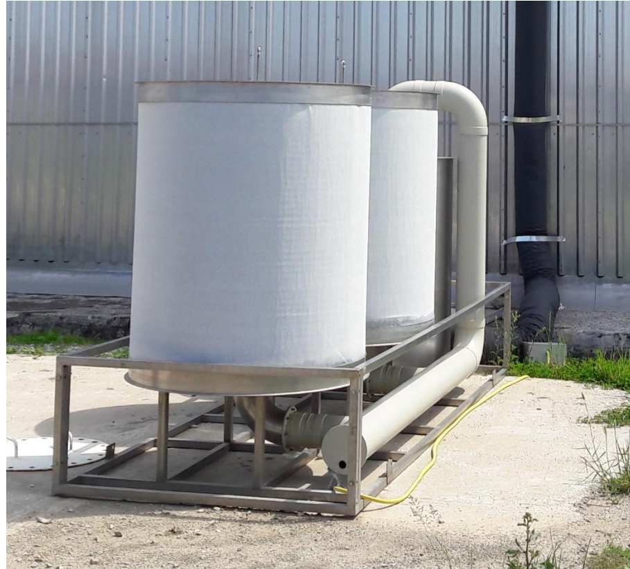
Esempio di filtro fotocatalitico su sfiato serbatoio
