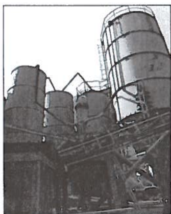
Foto 20 Silos di stoccaggio dei cementi Nella foto sono riportati 4 silos per lo stoccaggio dei cementi. Al centro di essi si nota il filtro a maniche per l'abbattimento della polvere durante la fase di caricamento degli stessi; nella zona sottostante il filtro è presente una tramoggia nella quale confluisce la polvere di cemento che viene recuperata ed inviata alla zona di carico delle autobetoniere
