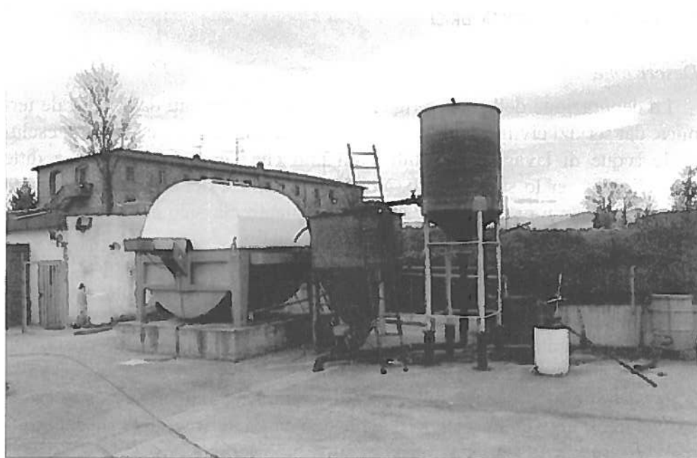
Foto 1 Particolare dell'impianto di depurazione acque con biofiltro
