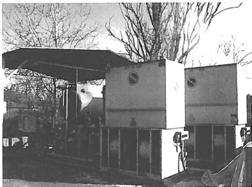
Foto 5 Impianto di addolcimento e raffreddamento acqua dei forni
