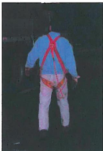
Fig. 67 Copertura manuale del carico: l'addetto è dotato di sistema di trattenuta dall'alto.
