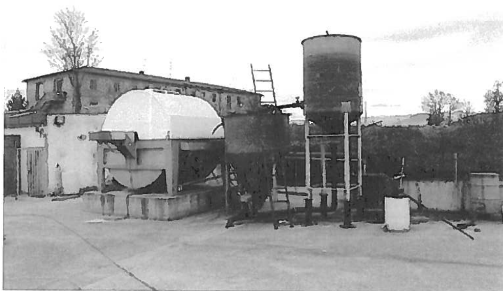
Fig. 71 Particolare dell'impianto di depurazione acque con biofiltro.
