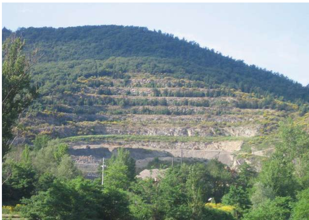
Foto 11 - Cava a gradoni con esempio di recupero vegetazionale
