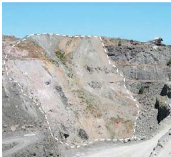
Foto 21 - Esempio di dissesti geomorfologici su di un versante di cava soda di affioramento di formazioni argillitiche
