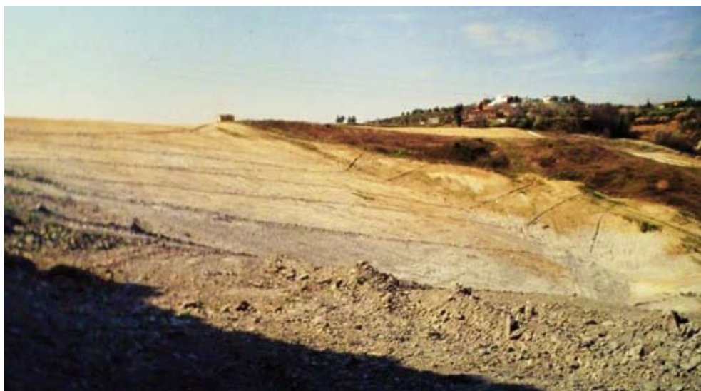
Foto 4 - Cava di argilla con sistemi di drenaggio delle acque superficiali
