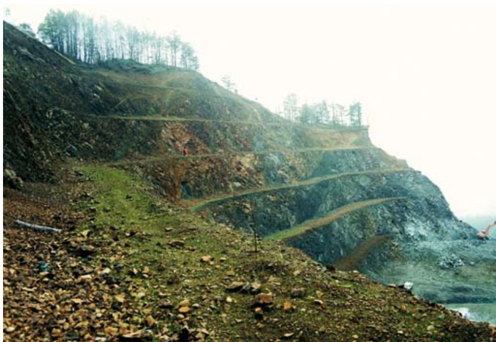
Foto 12 - Cava a gradoni in fase di riprofilatura e recupero
