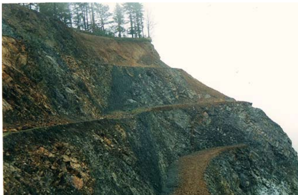
Foto 14 - Fase di recupero di cava con riporto di terreno sulla sommità dei gradoni
