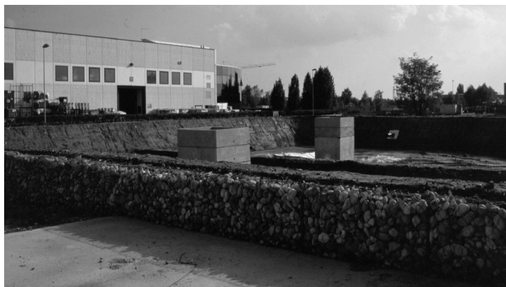
Visione dell'impianto presso la tintoria tessile: impianto a fanghi attivi e sedimentatore secondario
