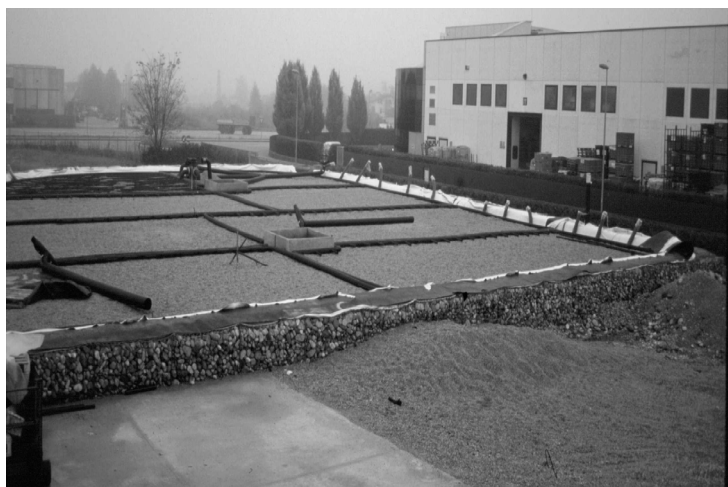
Visione delle fasi di costruzione dell'impianto di fitodepurazione
