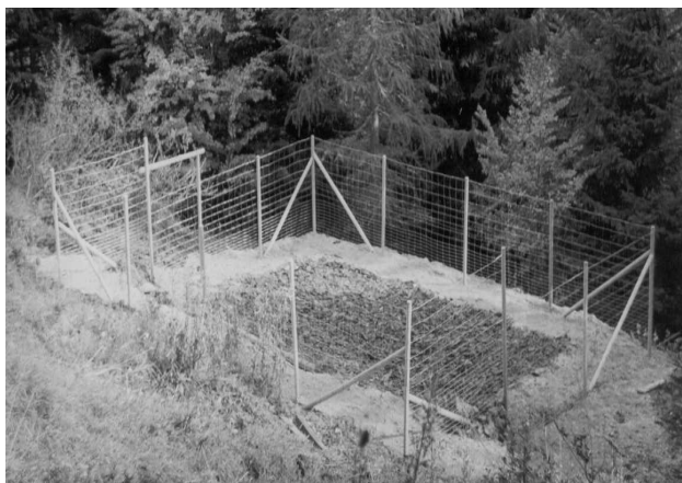
Visione dell'impianto di fitodepurazione a flusso verticale presso il Rifugio Grego nel Parco delle Alpi Giulie (UD)
