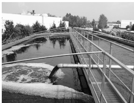
Visione dell'impianto presso la tintoria tessile: impianto a fanghi attivi e sedimentatore secondario
