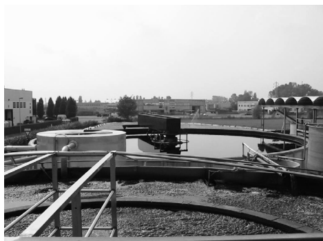
Visione dell'impianto presso la tintoria tessile: impianto a fanghi attivi e sedimentatore secondario
