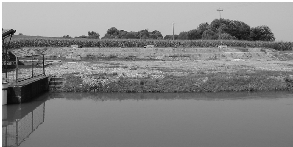
Visione dell'impianto dimostrativo di fitodepurazione a flusso verticale per la rimozione della carica batterica nelle acque a fini irrigui
