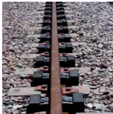
Figura 33 - Esempi di assorbitori lungo i binari [da Q-City TIP4-CT-2005-516420, “Quiet City Transport” DELIVERABLE D3.9, 2006]
