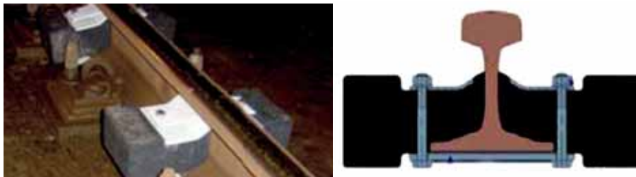
Figura 38 I - Assorbitori leggeri CDM (in nero) fissati mediante piatti d'acciaio [da Q-City TIP4-CT-2005-516420, "Quiet City Transport" DELIVERABLE D3.9, 2006]
