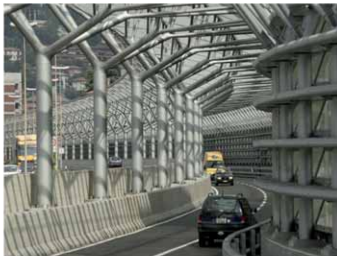
Figura 17 a, b, c, d - Viste delle barriere antirumore sull'autostrada A2 all'altezza di Chiasso [da www.tubosider.it ]
