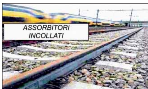
Figura 36 - Assorbitori con fissaggio meccanico e incollati [da Benton D., Engineering Aspects of Rail Damper Design and Installation , 2006]
