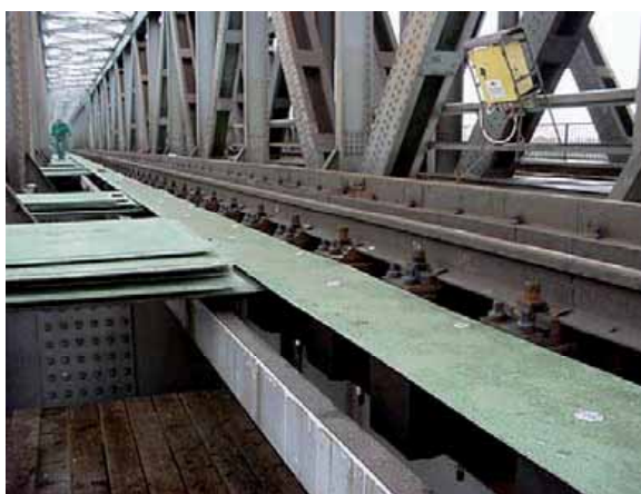
Figura 39 - Esempio di desolidarizzazione dei binari dalla struttura di un ponte, mediante inserimento di smorzatori in materiale composito [da Q-City TIP4-CT-2005-516420, "Quiet City Transport" DELIVERABLE D3.9, 2006]
