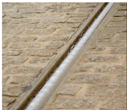
Figura 32 - Esempi di binario annegato, su linee urbane: a sinistra, in pavimentazione in pietra [da Q-City TIP4-CT-2005-516420, “Quiet City Transport”, DELIVERABLE D3.9, 2006]; a destra, in terreno vegetale.
