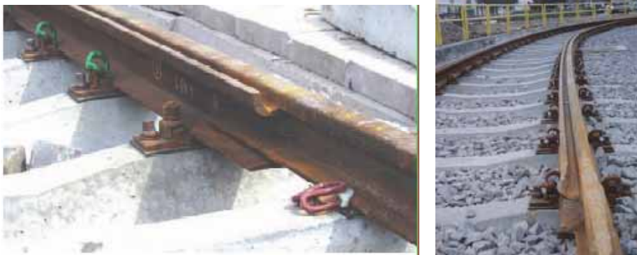
Figura 40 - Smorzatori su traversine di cemento [da Dedu I., Light Rail Helps Solve Capacity Crisis , 2008]
