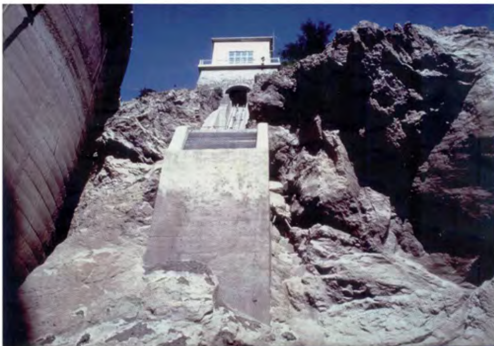
Foto 6, Diga di Vicaglia , particolare dell'opera di derivazione con griglia
