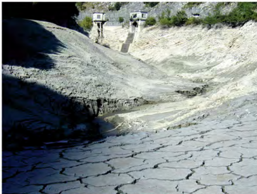
Foto 14, Diga di Turríte Cava, (Comune di Borgo a Mozzano - Lucca), Torrente Turríte Cava, Bacino del Fiume Serchio, vista del bacino svasato, dei sedimenti di interrimento disseccati e delle opere di derivazione
