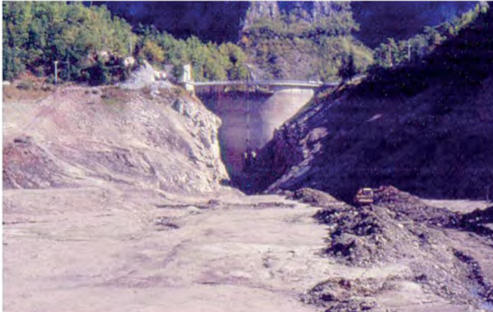
Foto 5, Diga di Vicaglia, (Comune di Sillano – Lucca), Torrente Fosso a Corte, Bacino del Fiume Serchio, vista del bacino svasato con accumulo dei materiali di interrimento
