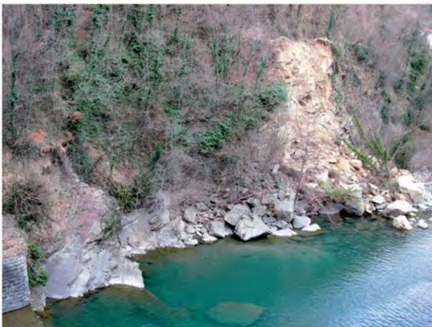
Foto 4, Diga La Lima, dissesto in sponda sinistra subito a valle della diga
