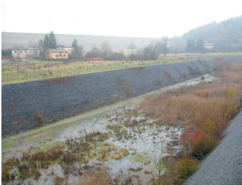
Foto 20, Diga di Bilancino (Comune di Barberino di Mugello - Firenze), vista del paramento di valle sullo sfondo e del canale scolmatore in primo piano
