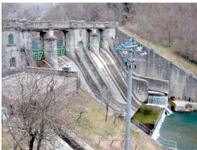
Foto 2 - Diga La Lima, particolare del paramento di valle e degli sfioratori di superficie
