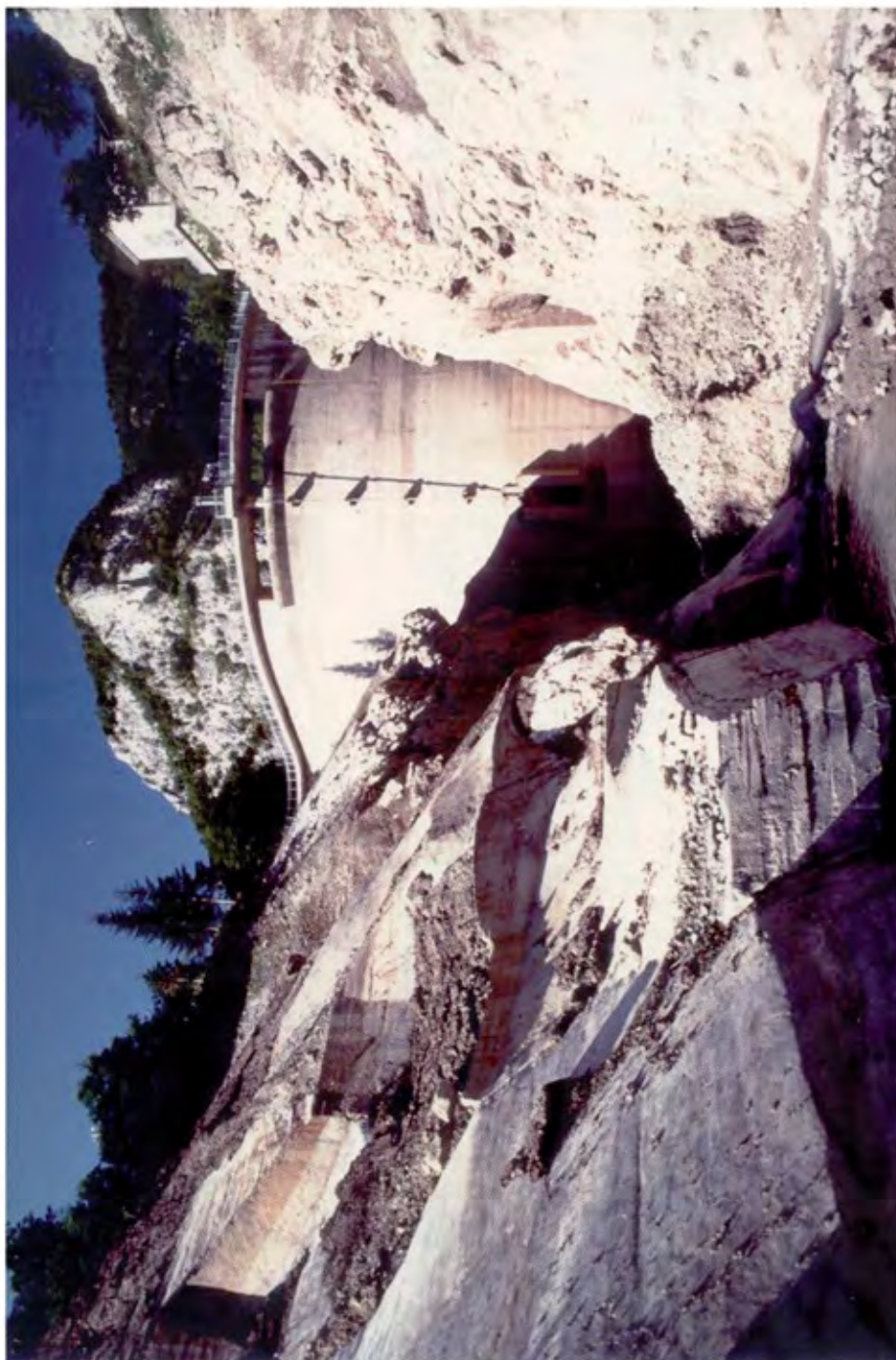
Foto 7, Diga di Vicaglia, vista dell'interno del bacino svasato con parziale asportazione dei sedimenti
