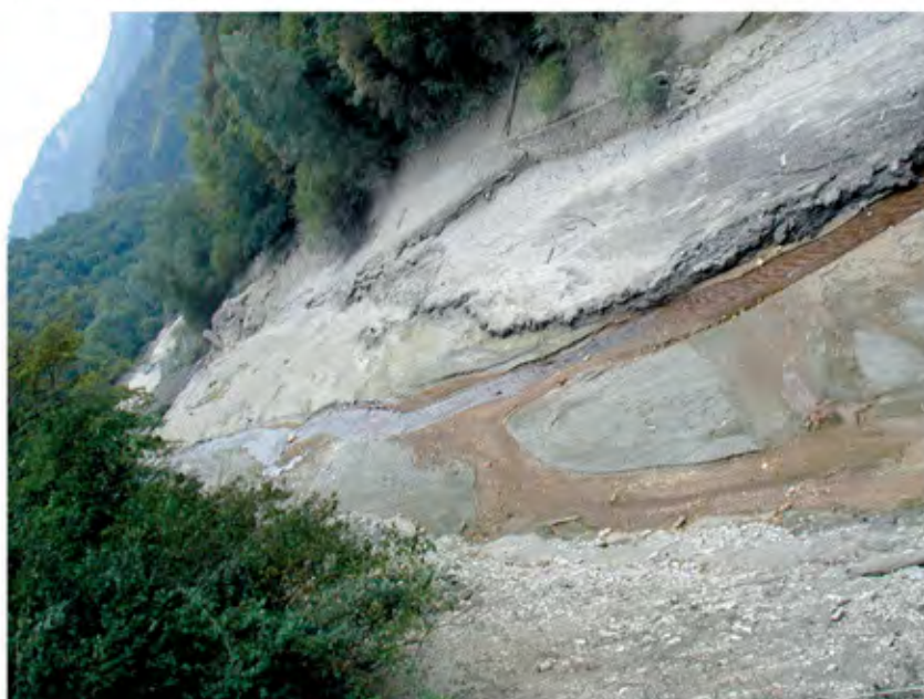
Foto 17, Diga di Turrite Cava, vista del fondo del bacino svasato, dei materiali di interrimento e del canale di deflusso
