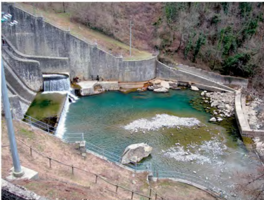
Foto 3, Diga La Lima, particolare della vasca di smorzamento a valle della diga
