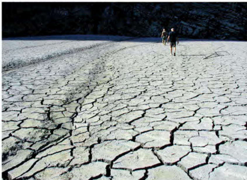
Foto 15, Diga di Turríte Cava, vista del bacino svasato e dei sedimenti di interrimento disseccati
