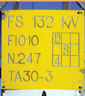
Targa con la dicitura "FS" presente sui sostegni delle linee di RFI SpA che riporta la tensione nominale, la disposizione delle fasi, il tipo di testa e il numero progressivo del sostegno.
