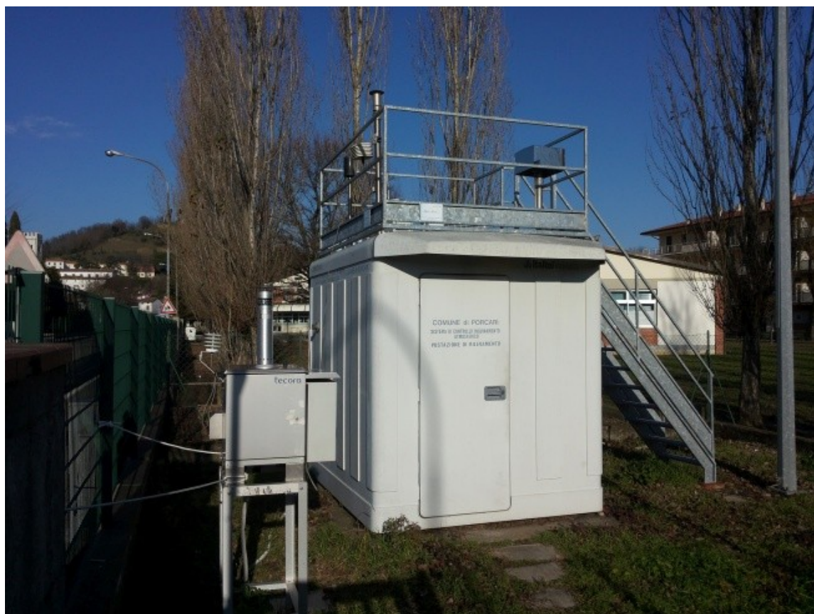
Figura 3: la stazione di monitoraggio con installazione a fianco del campionatore gravimetrico "Skypost" per la determinazione delle concentrazioni di PM10
