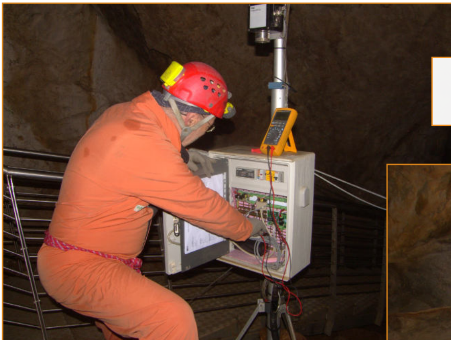
Fig. 9.15 - Operazione di manutenzione centralina meteorologica Galleria del Venerdì.
