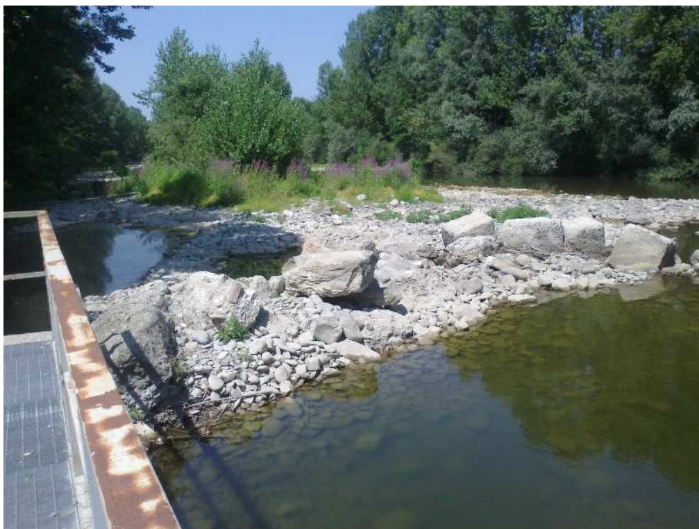
Buonriposo a valle della centralina
