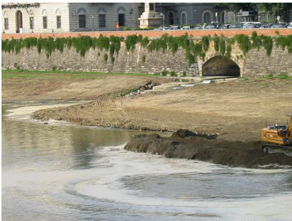
Lavori in alveo a Santa Rosa ( foto n.4)
