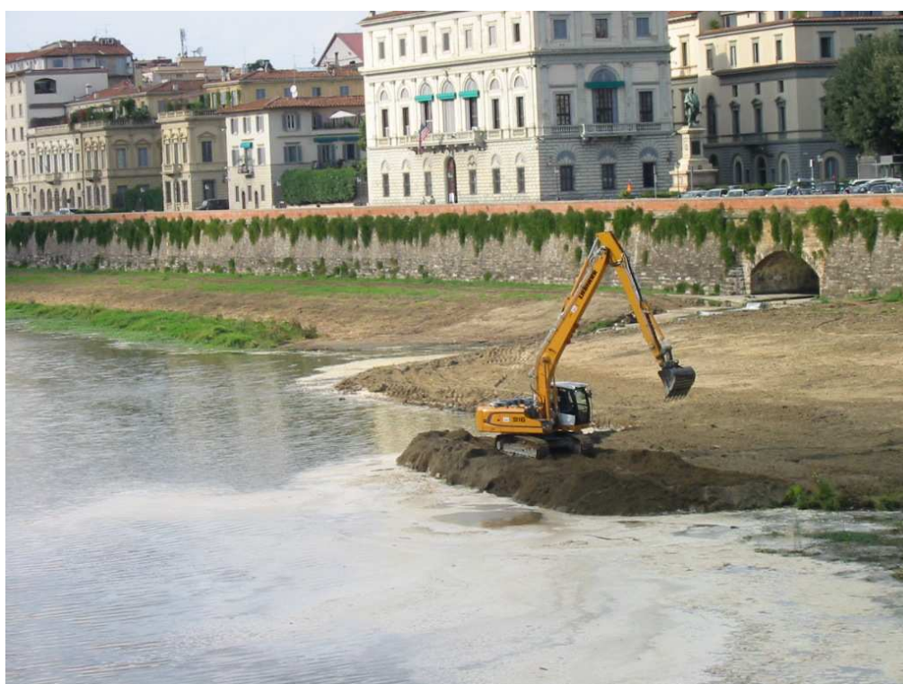
Lavori in alveo a Santa Rosa ( foto n.2)
