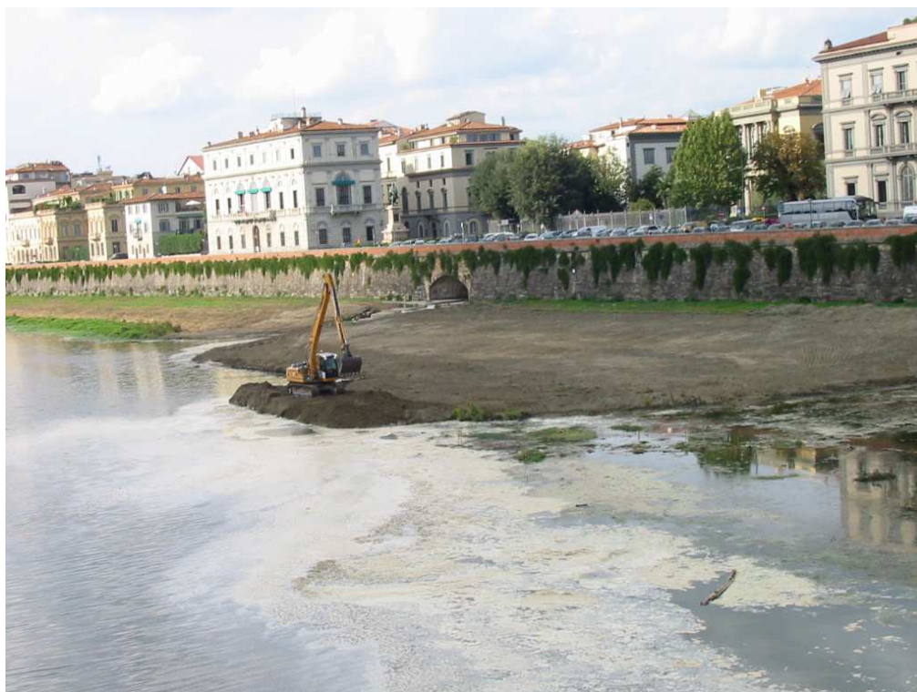
Lavori in alveo a Santa Rosa ( foto n.1
