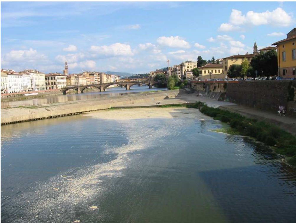
Lavori in alveo a Santa Rosa ( foto n.6)
