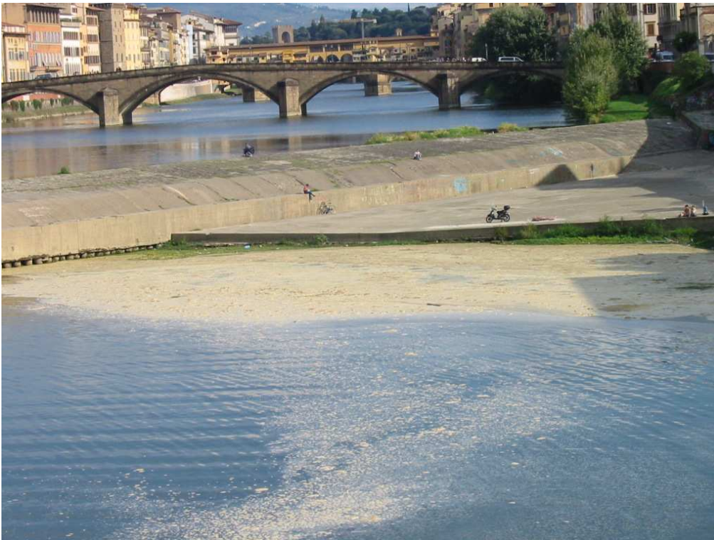
Lavori in alveo a Santa Rosa ( foto n.5)
