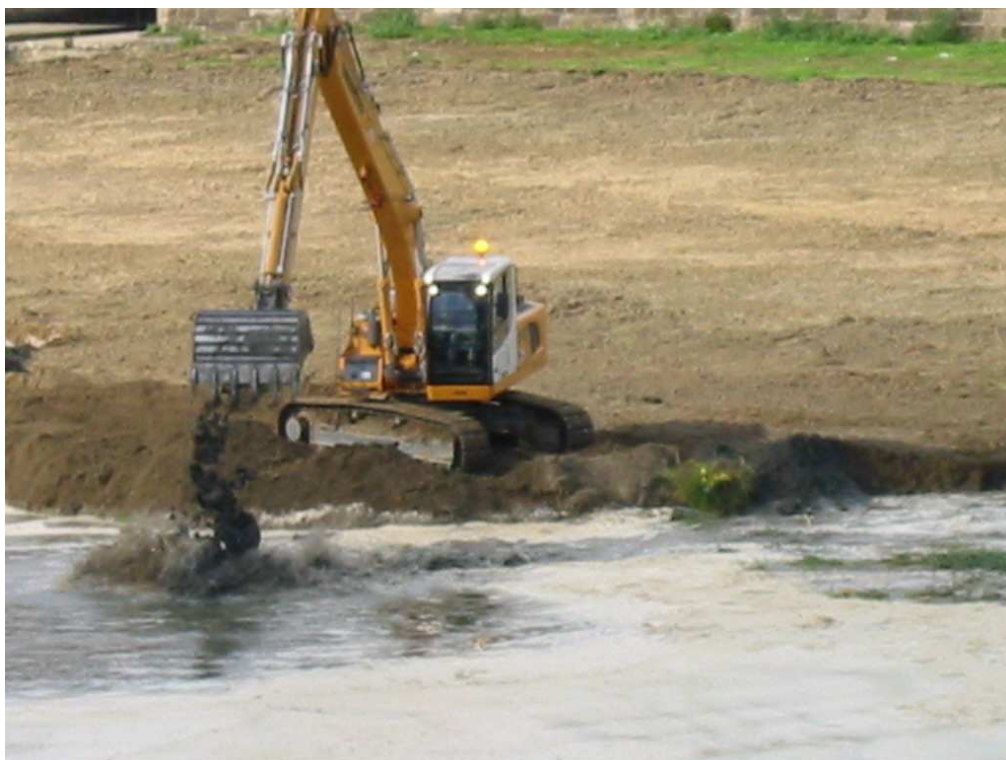
Lavori in alveo a Santa Rosa ( foto n.3)
